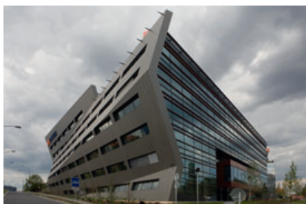
Administrativní objekty BB Centrum, A a E | Praha 4 Kompletní dodávka betonů pro zakládání a železobetonové konstrukce
