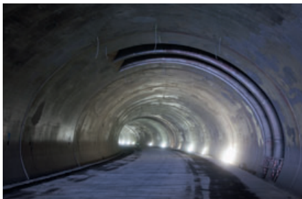
Městský okruh, tunel Blanka | Praha 7, 8 Dodávka stříkaných betonů, betonů pro definitivní ostění tunelů a vozovkových betonů
