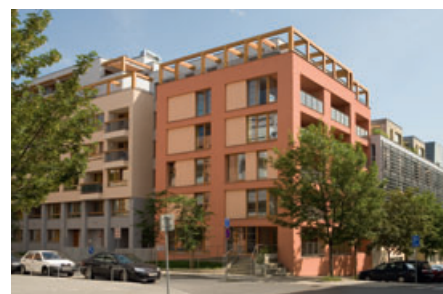
Rezidence Nový Anděl | Praha 5 Kompletní dodávka betonů
