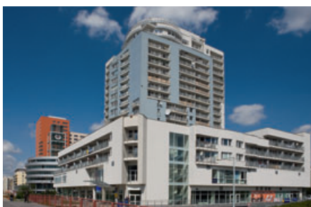
Polyfunkční dům Sluneční náměstí | Praha 13 Kompletní dodávka betonů
