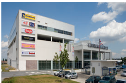
Obchodní centrum Chodov | Praha 4 Dodávka betonů pro železobetonové konstrukce
