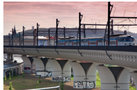
Železniční přivaděč Nové spojení | Praha 1, 3, 9 Kompletní dodávka samozhutnitelných betonů pro mostní konstrukce, dodávka betonů stříkaných a betonů pro definitivní ostění tunelů
