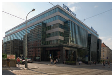
Administrativní centrum Luxembourg Plaza | Praha 3 Kompletní dodávka betonů pro železobetonové konstrukce
