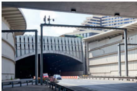
Městský okruh, Strahovský tunel | Praha 5, 6 Dodávka stříkaných betonů, betonů pro definitivní ostění tunelů a vozovkových betonů
