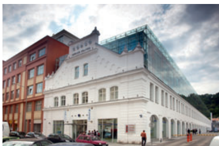
Administrativní budovy Corso Karlín I a II | Praha 8 Kompletní dodávka betonů pro zakládání a železobetonové konstrukce
