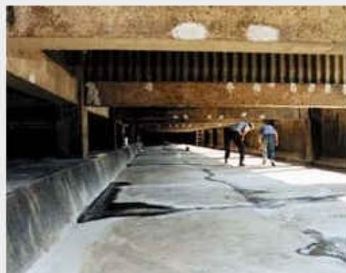
**Sanace:** Průsaky bazénů chladicích věží v délce asi 400 m byly odstraněny použitím materiálů XYPEX Concentrate a XYPEX Patch'n Plug. Na suchý povrch bazénů byly pak naneseny epoxidové ochranné nátěry. Provedení: Chladicí věže a. s., červen 1995
